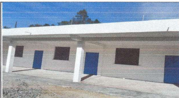
Foto 3: repello de paredes modulo aulas
