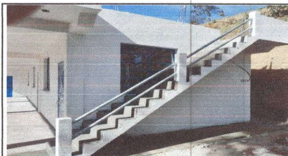
Foto 6: colocacion de baranda
