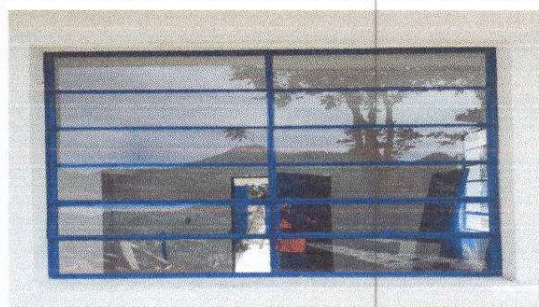
Foto 4: colocacion de ventanales modulo aulas
