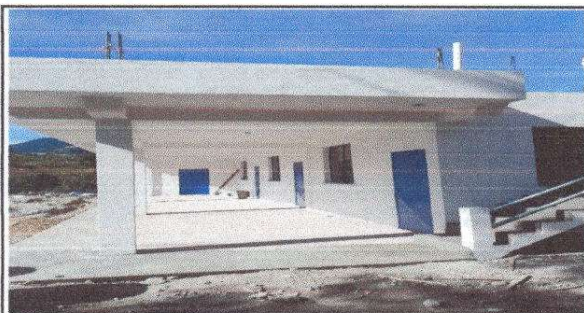
Foto 5: fundicion de torta de piso corredor y banqueta
